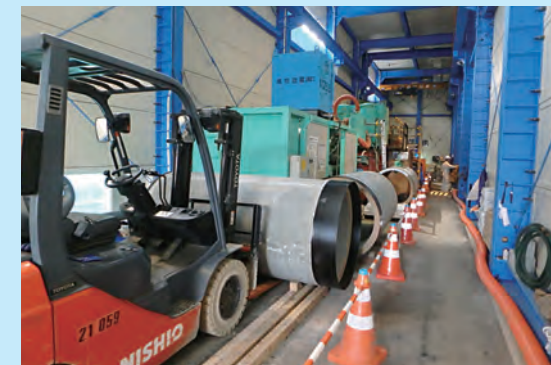
推進工法施工時
