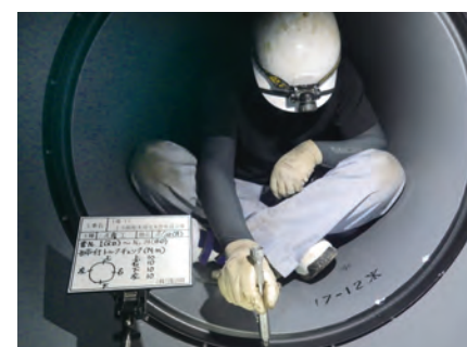
押輪用ボルトのトルク管理
