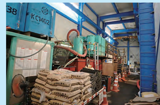
シールド工法施工時
