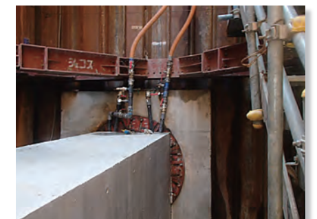
中込充填前状況 (発進立坑側)
