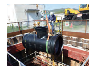
分岐用立坑内への 二受T字管の吊り降し状況
