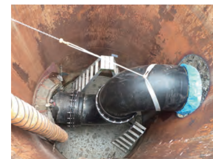
到達立坑内配管φ800 90°曲管Sベンド部 土留工:ケーシングφ3000
