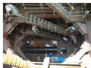
発進立坑内への直管の吊り降し状況
