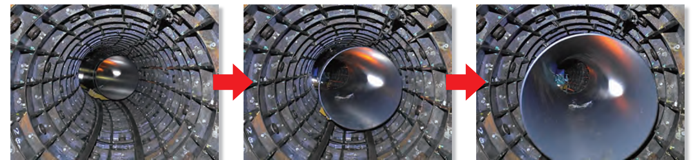
最小曲線半徑 R=15m 4m管(定尺管)通過狀況
