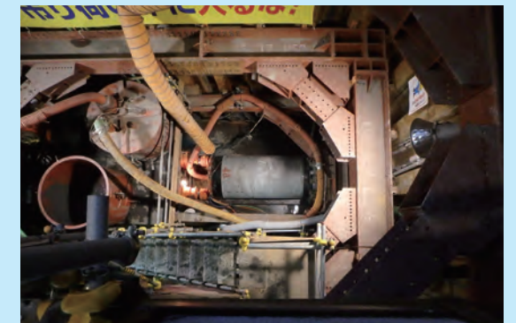
推進工法施工時
