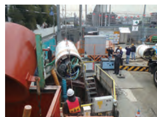
掘進機吊り降し状況
