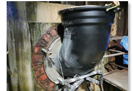
中込充填完了状況
