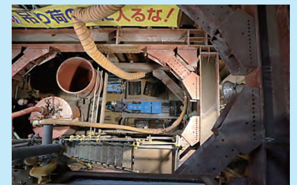
シールド工法施工時
