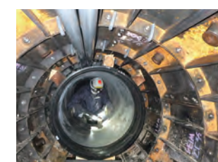
二次覆工時の 坑内作業状況
