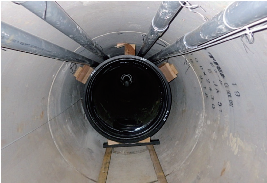
写真-5 本管の敷設状況
