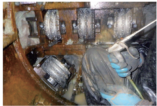
写真-4 ビット交換状況 (チャンバ内)
