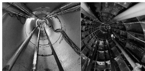
写真1 一次覆工施工状況
